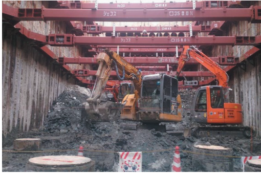
写真3 Eco ラム®工法の適用事例
